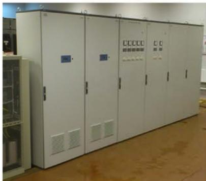
Рис. 2. Внешний вид СПТ на базе ЛИ-аккумуляторов КЦ Комсомольского ЛПУ МГ ООО «Газпром трансгаз Югорск»
